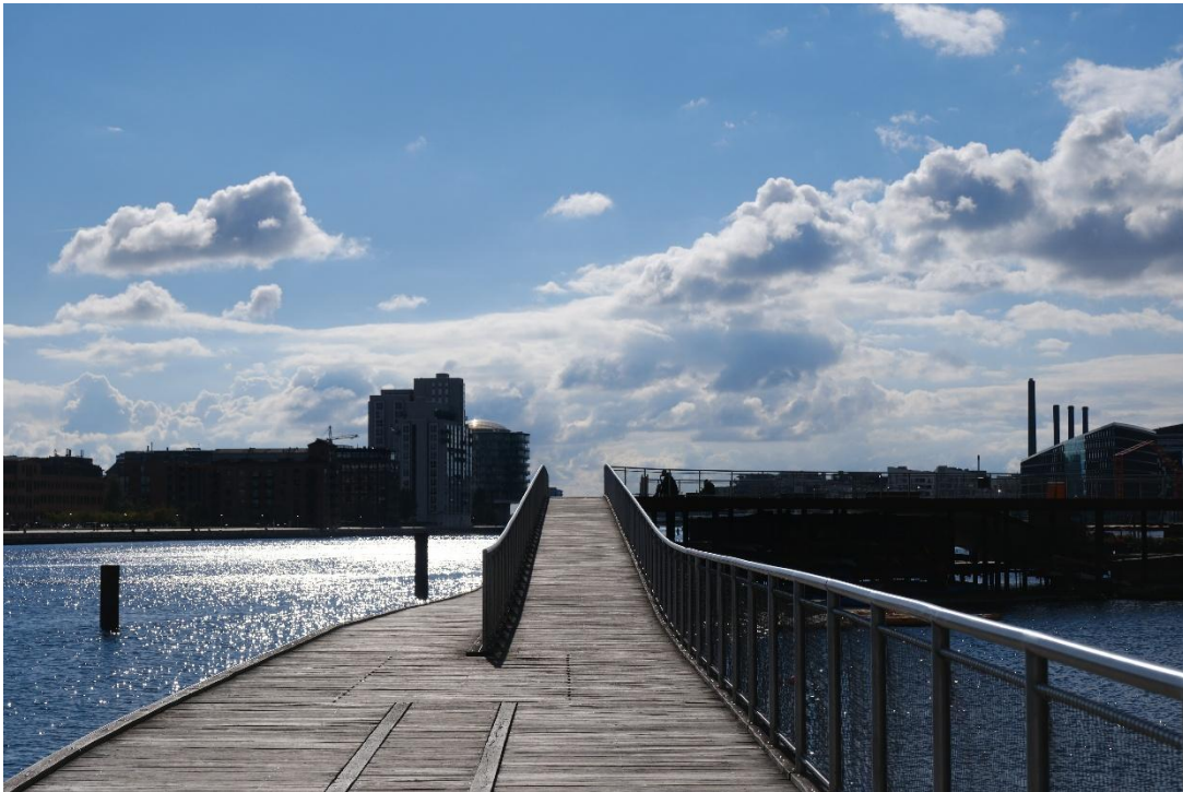
Un chemin vers l'avenir (port de Copenhague).
